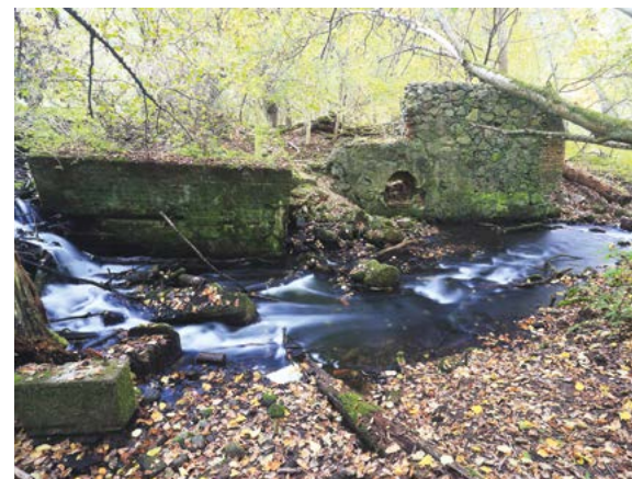
RUINY MŁYNA WODNEGO na Ilance, poniżej jeziora Pniów.
