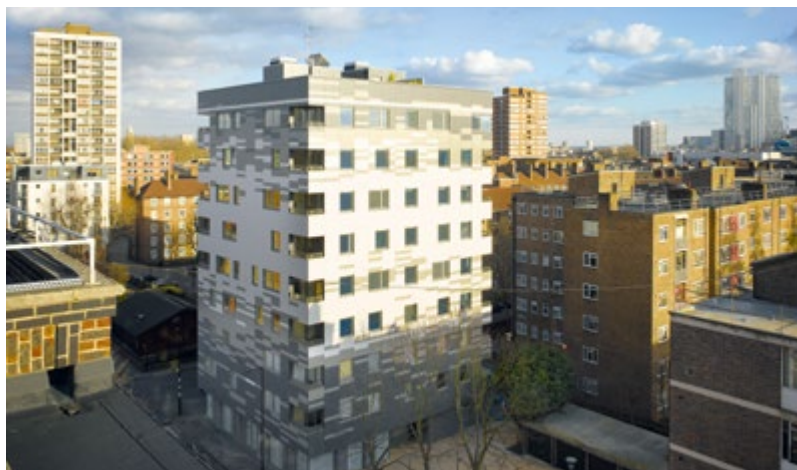
LONDYŃSKI Stadthaus Murray Grove, zbudowany w 2009 r.
